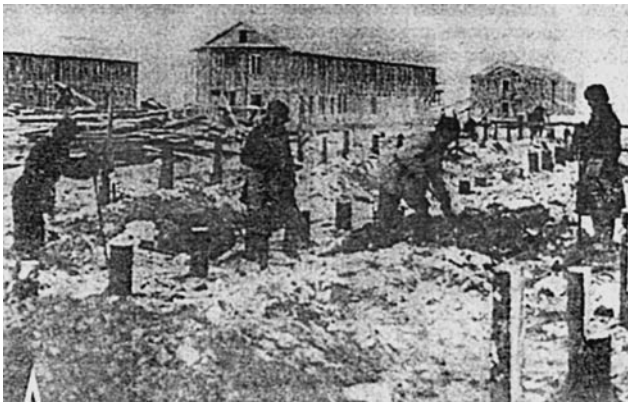
Начало строительства каркасных домов. 1934.
